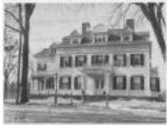
458 Old Post Road (FF_BLDGS_458Old Post Rd_6)
