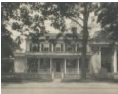
480 Old Post Road (FF_BLDGS_480Old Post Rd_1)
