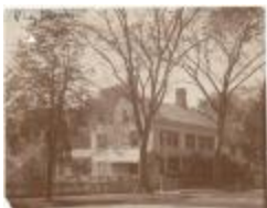
543 Old Post Road (FF_BLDGS_543Old Post Rd_1)
