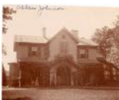
363 Old Post Road (FF_BLDGS_363Old Post Rd1)
